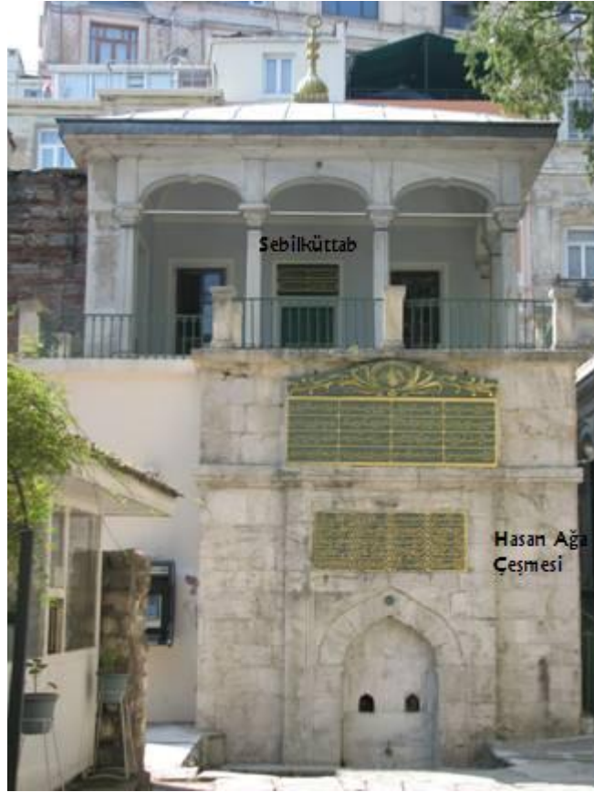
Şekil 23: Hasan Ağa Çeşmesi ve Sebilkütâb binası. (Fotoğraf Yavuz Özdemir)
