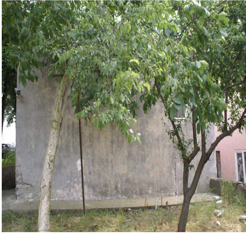
Resim 58: Yapının örgüsü içinden taş – tuğla karışık örgülü, üzeri ise sıvalıdır.
