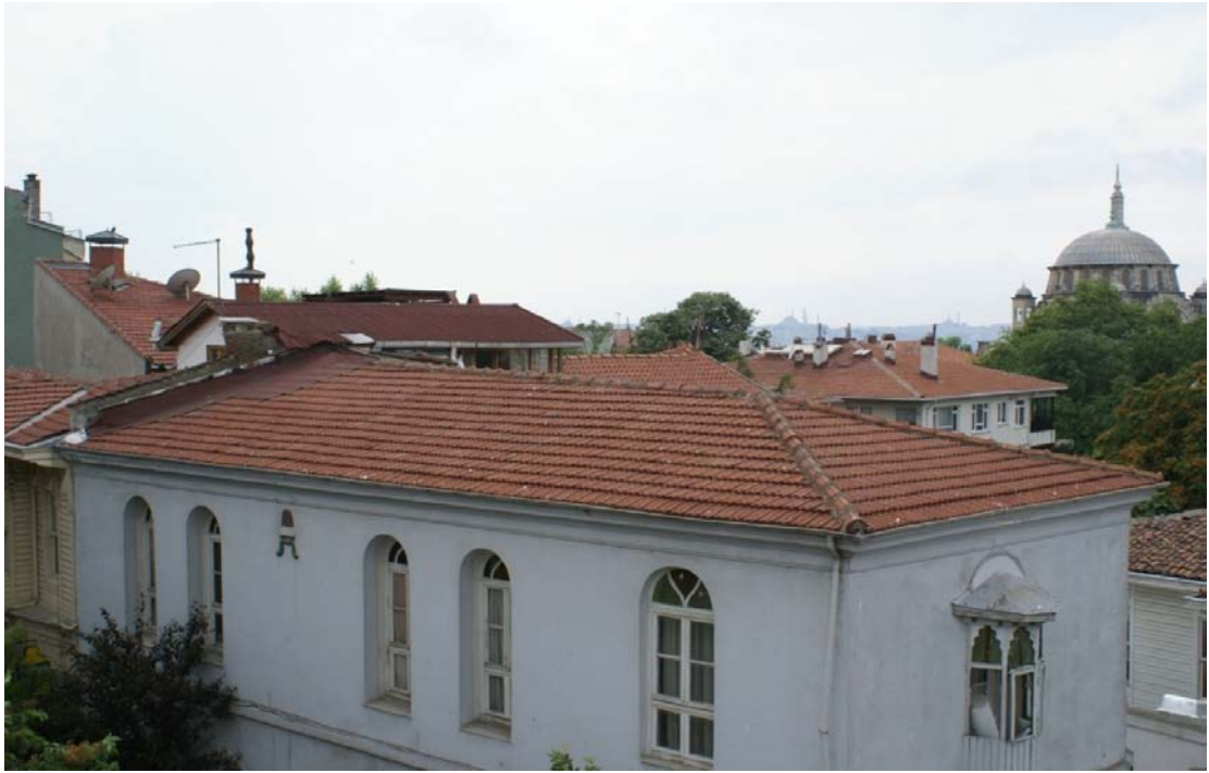
Resim 14: Semahane-Türbe Binası Çatı Örtüsü
