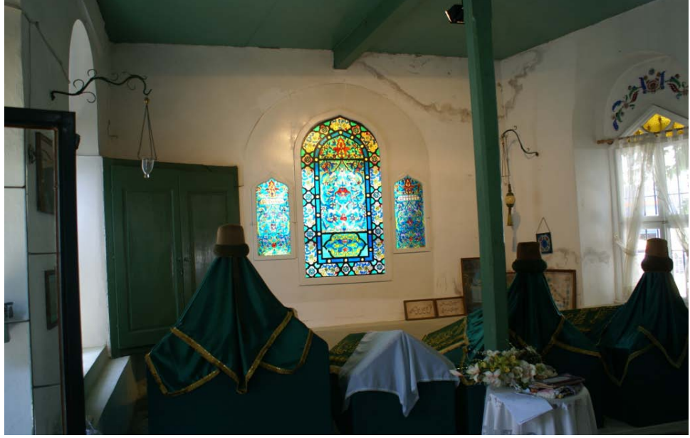
Resim 26: Türbe içersinde ortasında 14x14 santimetre ebatlarında üç ahşap sütun bulunmaktadır. Bu sütunlar tavadaki ahşap kirişe saplanmaktadır.
