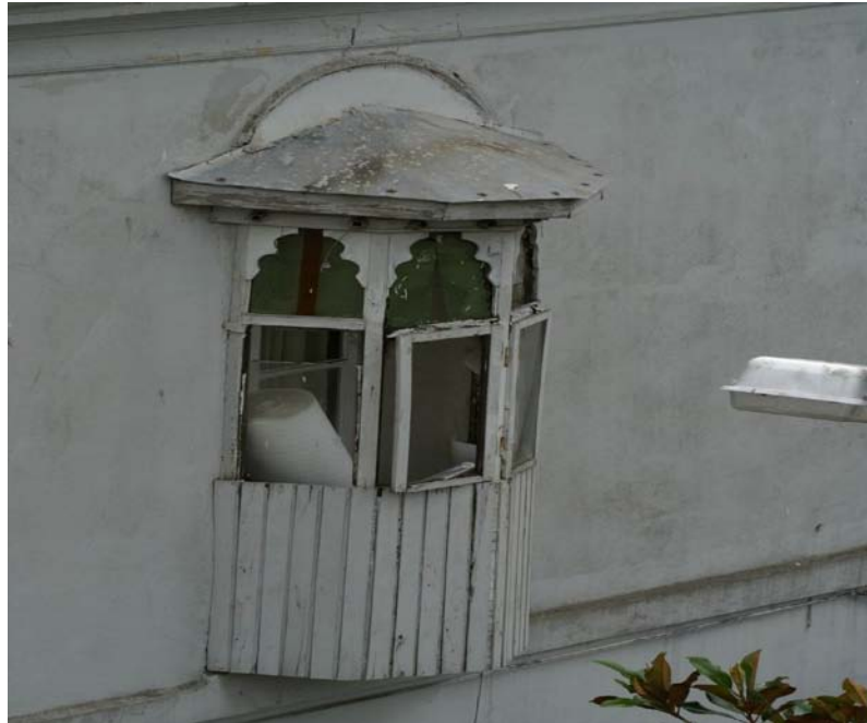
Resim 33: Yarım daire planlı mükebbireye. Basit bir korkuluk duvarına sahiptir ve beş adet kare kesitli ahşap sütun arasında kemer biçimli saçaklıklar vardır.
