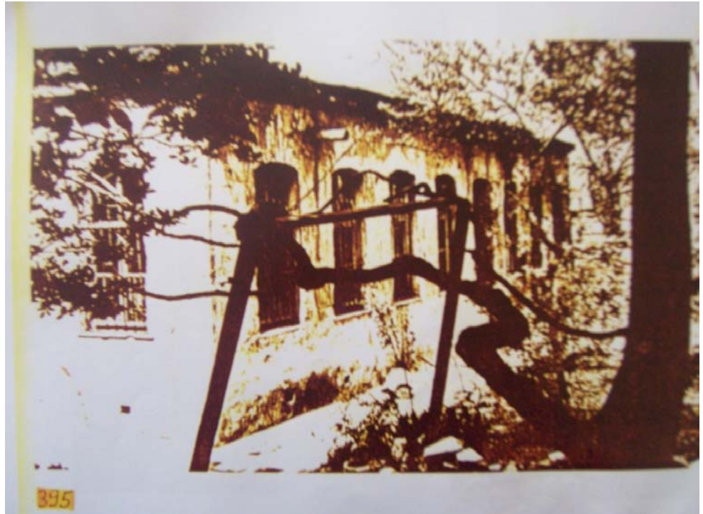
Resim 51: Dedegan Binası'nın moloz taş ve tuğla örgülü, sonradan sıvanan duvarları (Süheyl Ünver'in 42 numaralı defterinden alınan eski fotoğraf).
