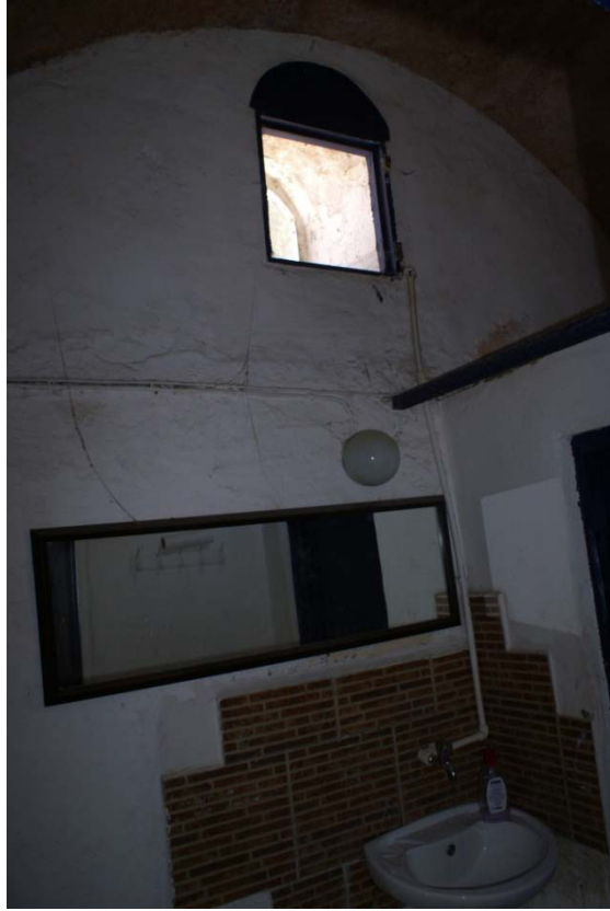
Resim 62: Yapı tek mekan bir su sarnıcından ibarettir. Zemini tuğla üst kısmı malta döşelidir. Kuzey cephesinde küçük tuğla kemerli bir pencere bulunur.
