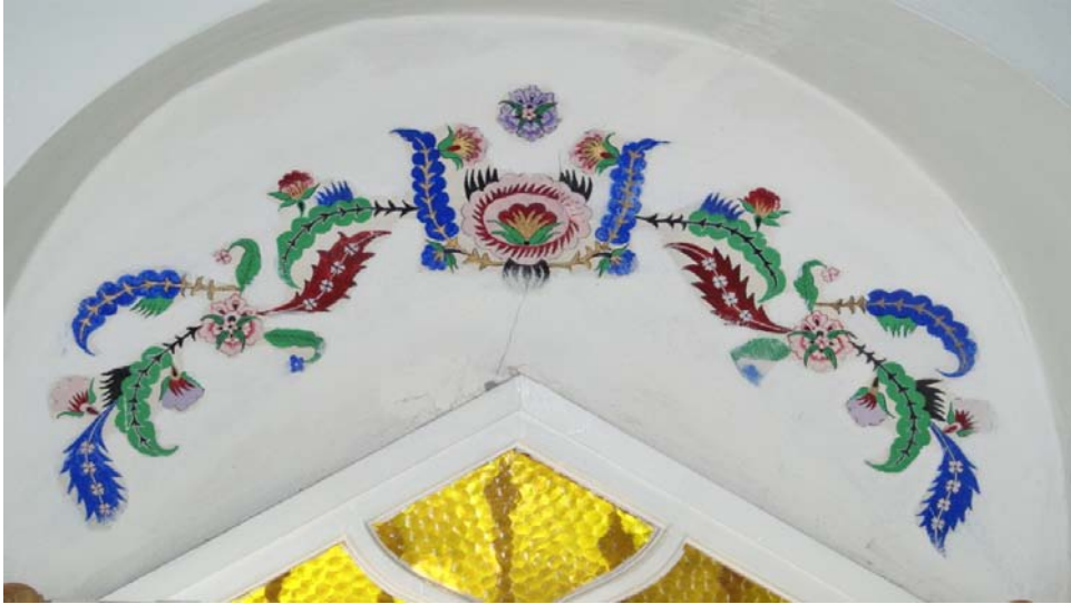
Resim 21: Dışarıdan üçgen kemerli olarak gözüken pencerelerin, iç kısımdan üst noktada yuvarlak bir nişle çevrelediği görülmektedir. Aradaki boşluk daha sonradan kalem işleri tezyin edilmiştir.
