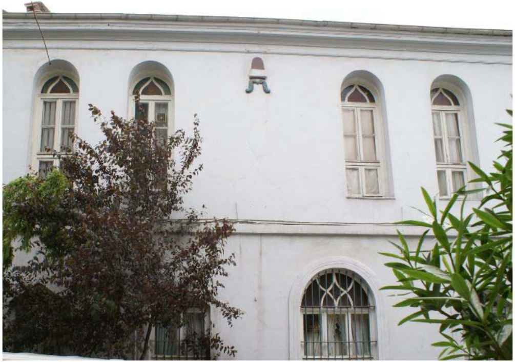
Resim 34: Semahane Dođu Cephesi'nin pencere düzeni
