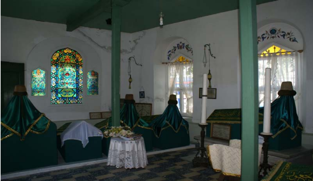
Resim 20: Türbe içersinden sepetkulpu biçimlere sahip pencereler
