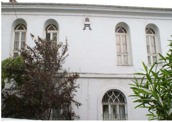
Resim 37: Semahane Doğu Cephesi'nin pencere düzeni
