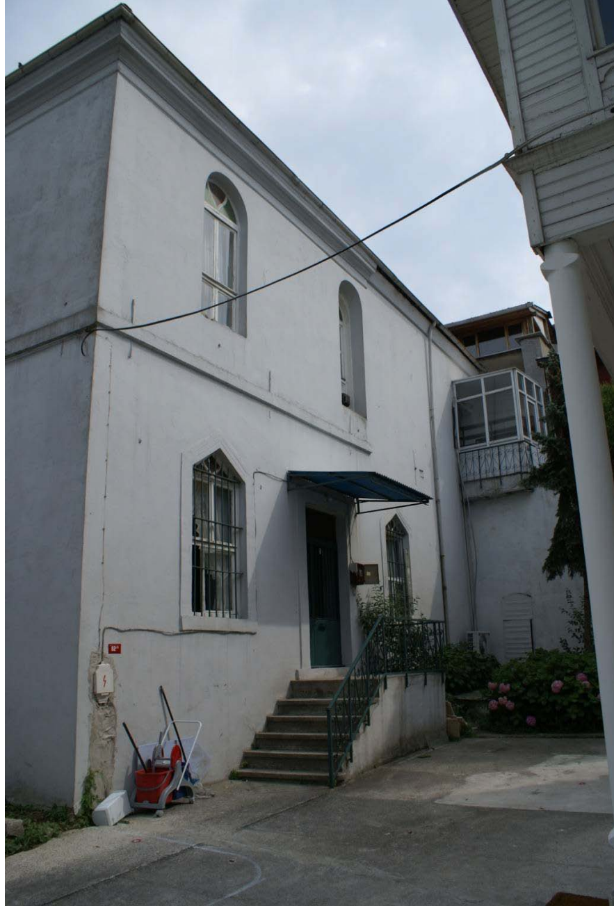
Resim 75: Türbe ve Semahane Binası.
