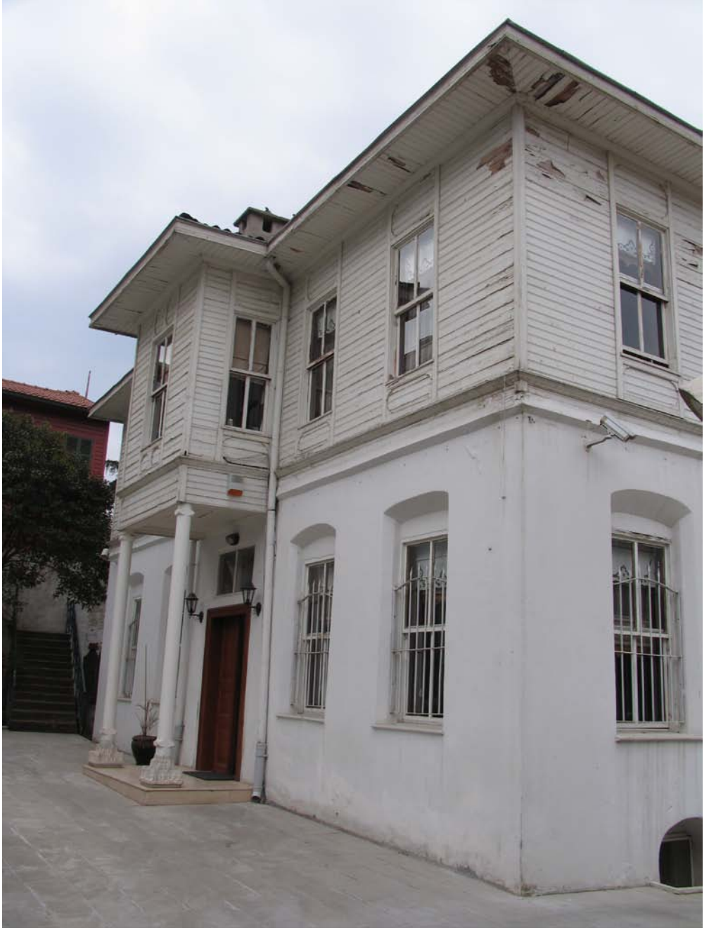
Resim 64: Selamlık Binası'nın Güncel Fotoğrafi
