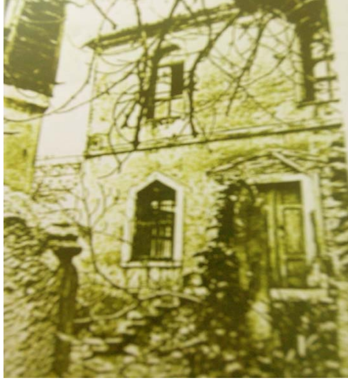
Resim 17: Semahane-Türbe Binası Giriş Cephesi
