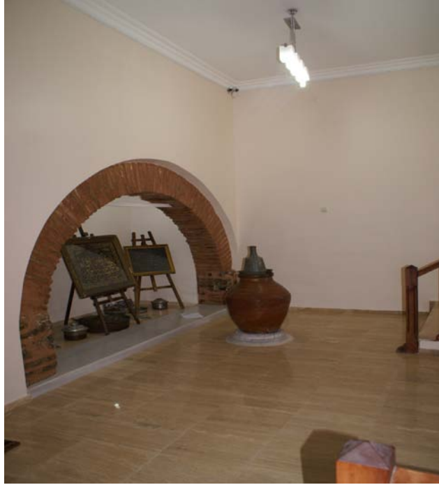
Resim 41: Selamlık – Mutfak Binası'nda yer alan yarım daire kemerli, tuğladan örülü ocak.
