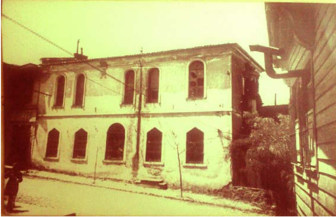
Resim 18: Semahane-Türbe Binası Doğu Cephesinden Görünüş (İsmail Hakkı Konyalı Kitaplığı - İsmail Hakkı Konyalı Arşivi - Selimiye)
