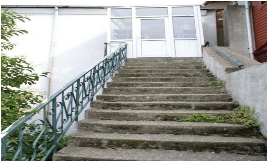
Resim 29: Semahaneye giriş ve girişi sağlayan merdivenlerin görüntüsü.
