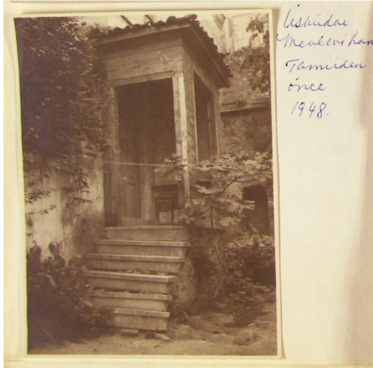
Resim 16: Semahane-Türbe Binası Giriş (Fotografın yanında tamirden önce 1948 ibaresi yer almaktadır).
