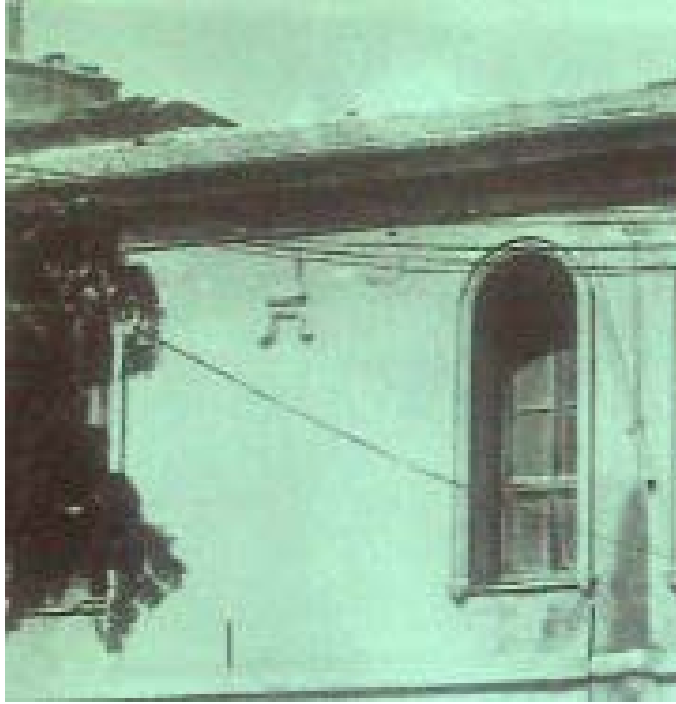
Resim 38: İç kısımdaki mihrap nişinin olduğu kısma denk düşen, dış cephedeki sıva ile yapılan “Mevlevi tacı” kabartması.
