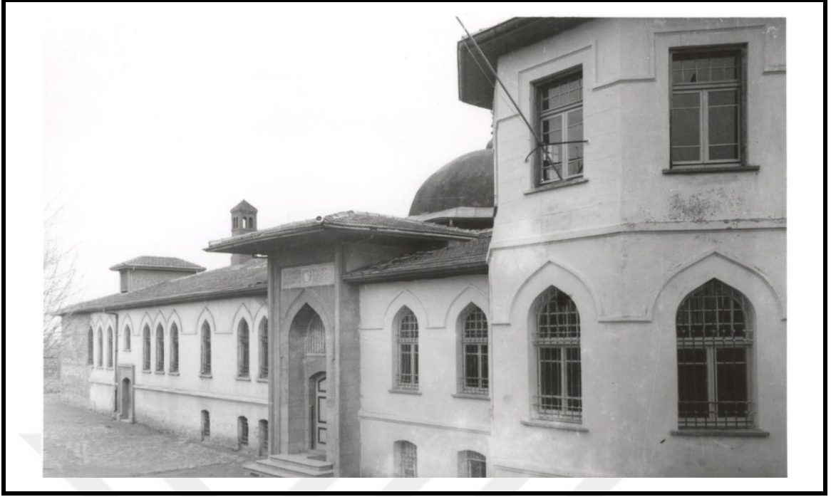
Şekil 3.103 Yenikapı Mevlevîhânesi Selamlık Binası avlu (doğu) cephesi [121]
