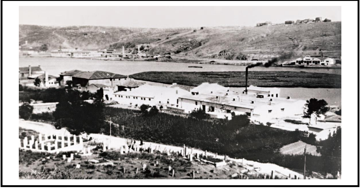
Şekil 3.261 Bahariye Mevlevîhânesi binalarının 1933'deki durumları, sağdan sola doğru önde cümle kapısı, solunda mescit, kıyıda selamlık, semahane-türbe, harem binaları, harem gerisinde mutfak ve hamam birimlerinin kara tarafından görünüşü [114]
