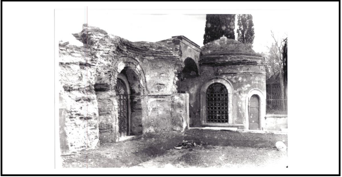
Şekil 3.104 Yenikapı Mevlevîhânesi sebilin yıkılmış görüntüsü [110]
