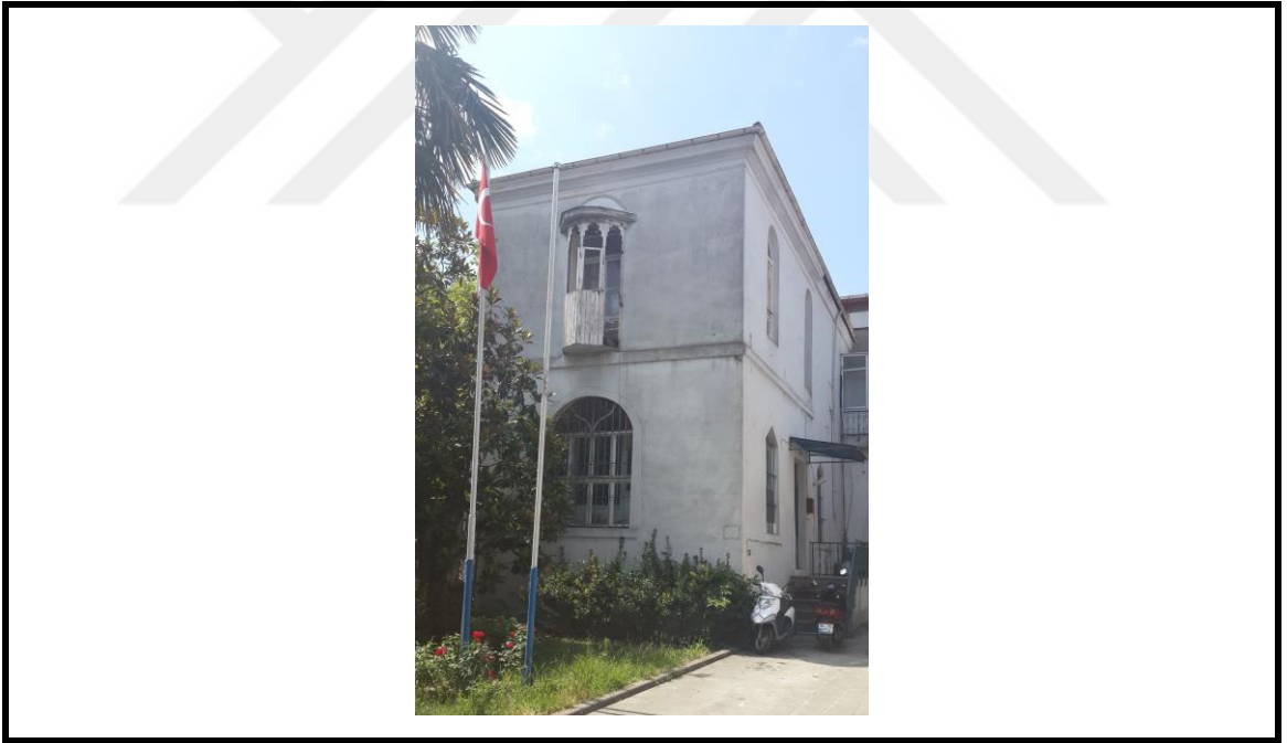
Şekil 3.230 Üsküdar Mevlevîhânesi Semahane-Türbe yapısının iç avludan görünüşü (Gökben PALA AZSÖZ'e ait fotoğraf)
