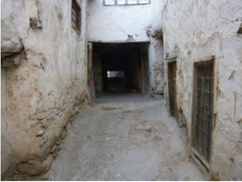
Resim: 7- Pirpınarı Sokağı'ndan bir kesit (örtme/tünel/eklenti).
