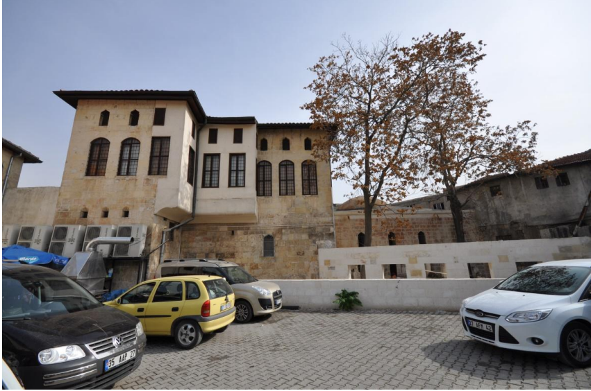
Fotoğraf 21.Selamlık Batı Cephesi- Ön Taraftaki Otopark (Develik)
