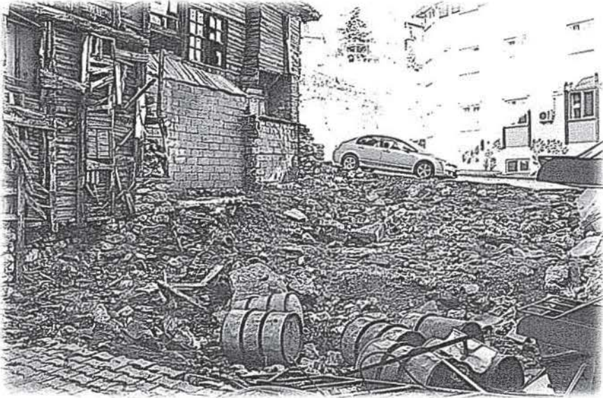
Resim 5- Eğirdir Mevlevihânesi'nin yan cephesi
