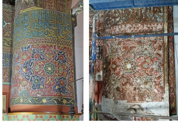
(Fot.19) Güney cephesi filpayelerin onarım önsesi ve temizlenmiş hali
