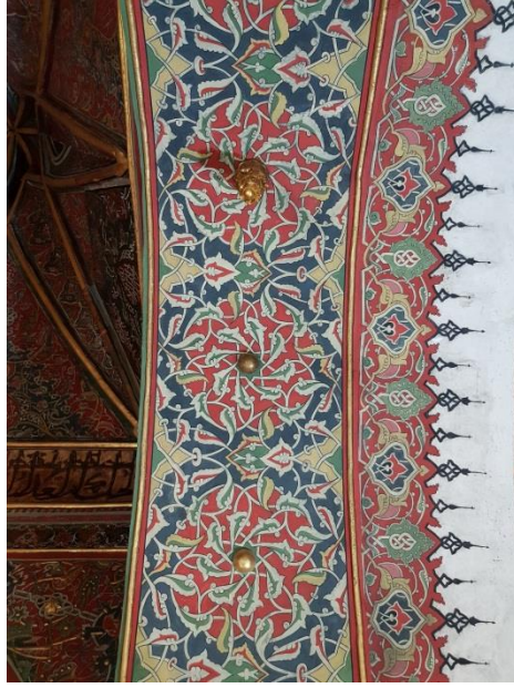
(Fot.13) Kuzey ve güney cepkeleri kemer içi (Onarım sonrası)
