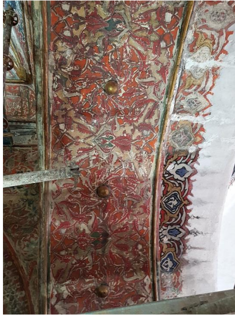
(Fot.14) Doğu ve batı cepheleri kemer içi (Onarım öncesi)
