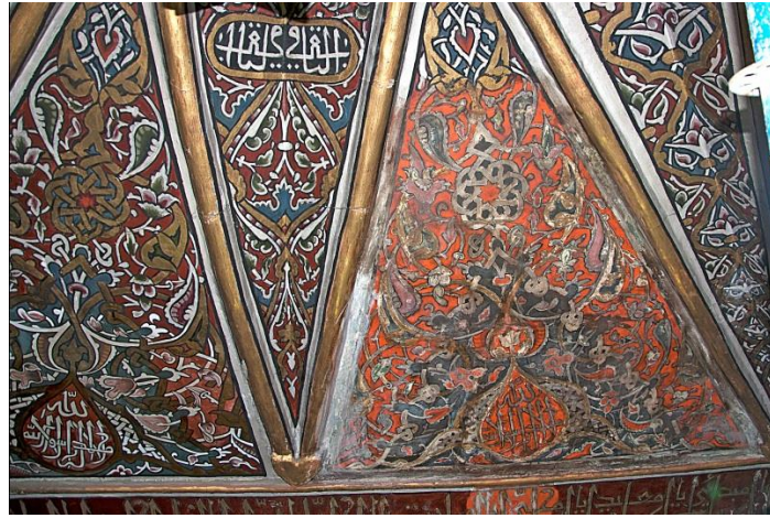
(Fot.5) Yıldız tonoz içinde raspa yapılan bölge
