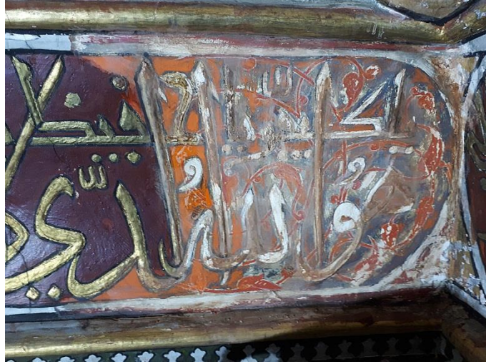
(Fot.9) Yıldız Tonoz kuşak yazısı temizlenen bölüm
