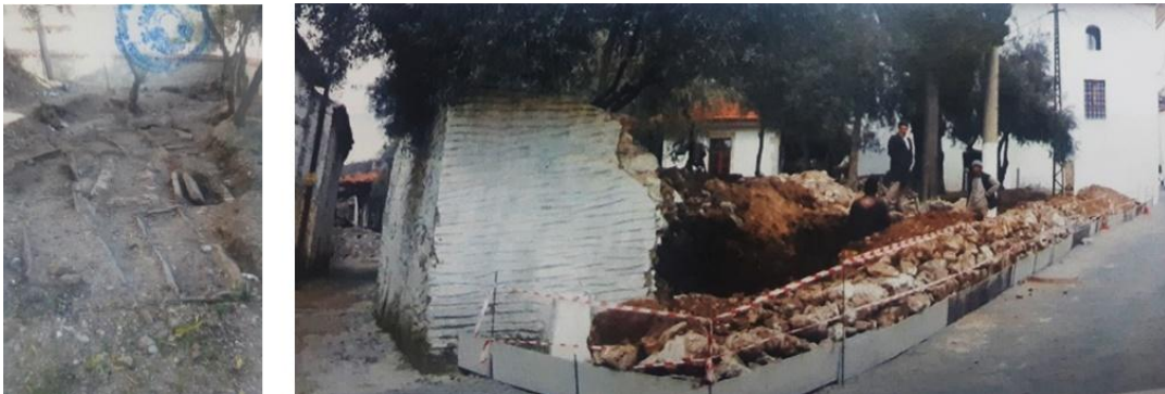
Fot. 10-11: Hazire alanının düzenlenmesi ve avlunun istinat duvarının yenileme çalışması sırasındaki hâli (Muğla Kültür Varlıklarını Koruma Bölge Kurulu Müdürlüğü Arşivinden).
