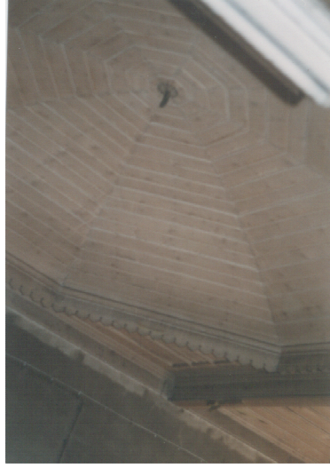
Şekil 3.79.Koridorda bulunan çıkmaların üzerini örten sekizgen ahşap kubbe,1998
