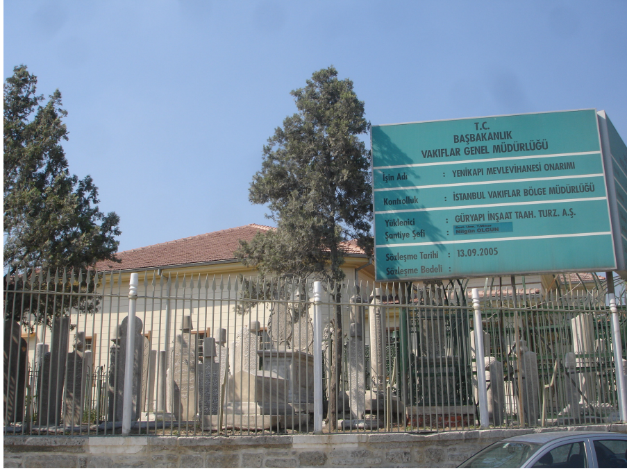
Şekil5.1.Mevlevihane'nin Restorasyon çalışmaları
