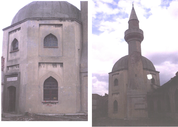
Şekil3.86 Mescidin cephesi, (İstanbul IV Numaralı Kültür ve Tabiat Varlıklarını Koruma Kurulu Arşivi)
