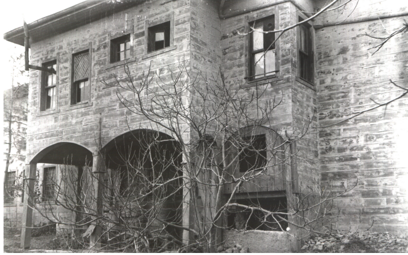
Şekil 3.54 Hünkar Mahfilinden geçilen odanın dış cepheden görünümü, (Encümen arşivi,1940)
