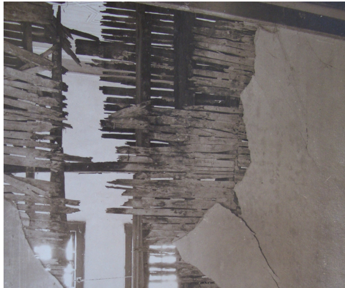
Şekil 3.38. Semahane Yapım Tekniğini Gösteren Fotoğraf,(1940 Encümen Arşivi)
