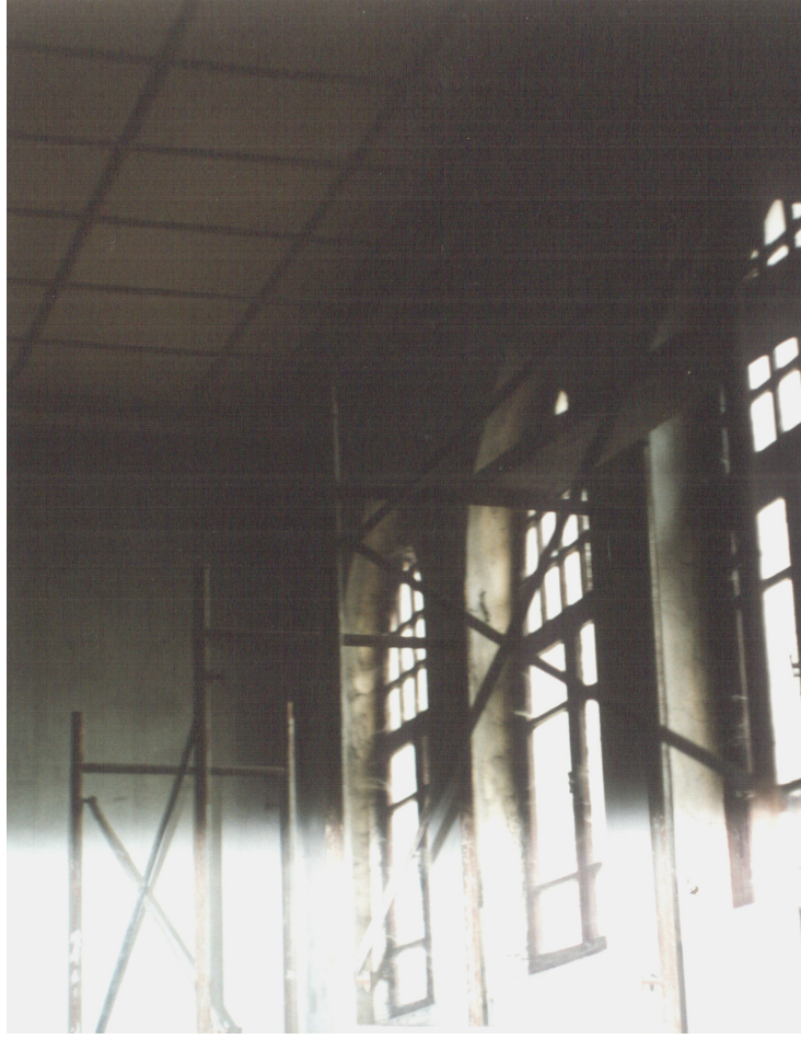
Şekil 3.20 Somathane deki 1989 onarımından kalan iskeleler (1998)
