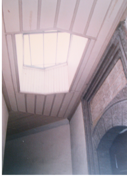
Şekil 3.60 Matbah giriş kapısı üzerinde bulunan tepe penceresi
