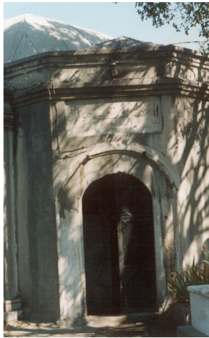
Şekil 3.95 Kütüphanenin giriş kapısı,1998
