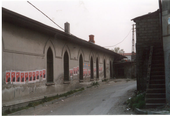
Şekil 3.82 Selamlık binasının batı cephesinde bulunan pencereler,1998
